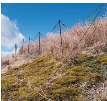
防護柵内で生長する植物
